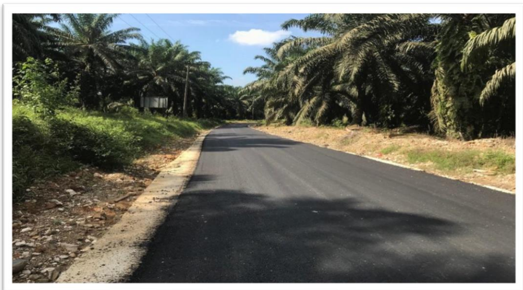
Foto 3.2.3 Jalan Desa dan Jalan Kabupaten
